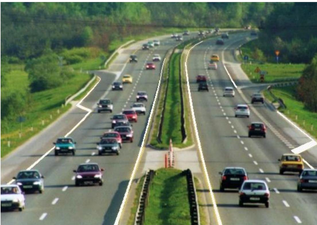
Fotografija br. 20. Autoput cijelom svojom dužinom ima izvedene saobraćajne trake za prinudno zaustavljanje vozila
