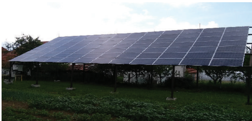
Slika 1. Izgled fotonaponske elektrane 20 kW Đurđevik
